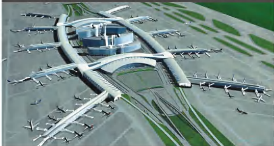
▼ 白云机场T2航站楼
